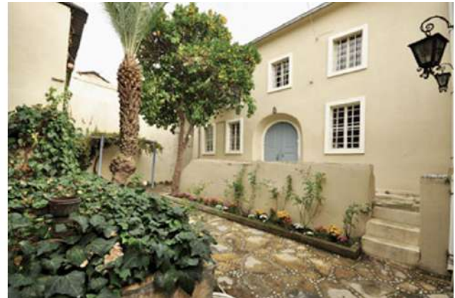
Görsel 6. Batı Cephe
