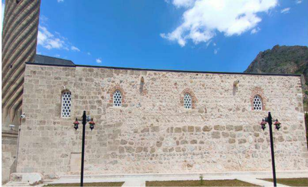
Fotoğraf 5: Batı Cepheden Görünüm (07.05.2025)
