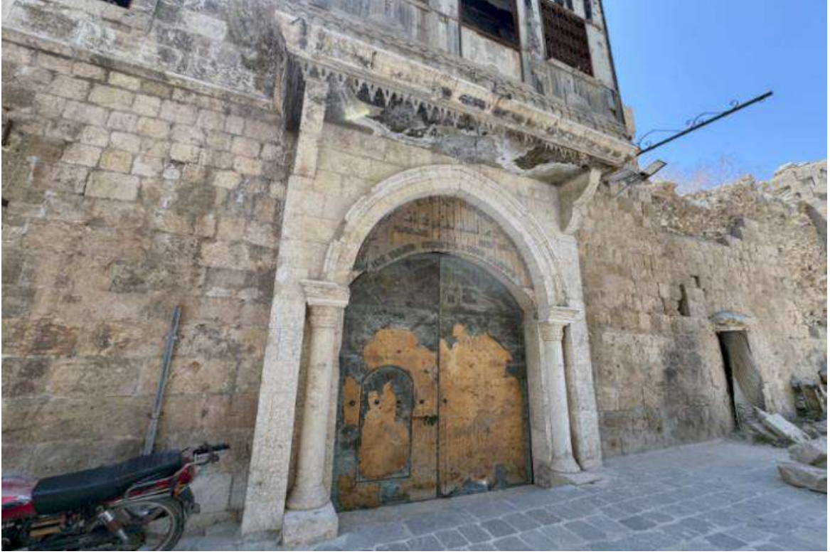
Resim 3: Dokakin Zade / Adiliyye Cami ve Külliyesi binası fotoğrafı (Sabit Narin, 2025)
