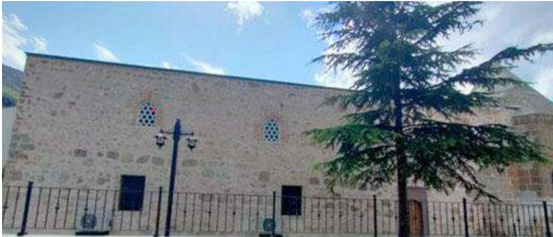
Fotoğraf 3: Doğu Cepheden Görünüm( 07.05.2025)
