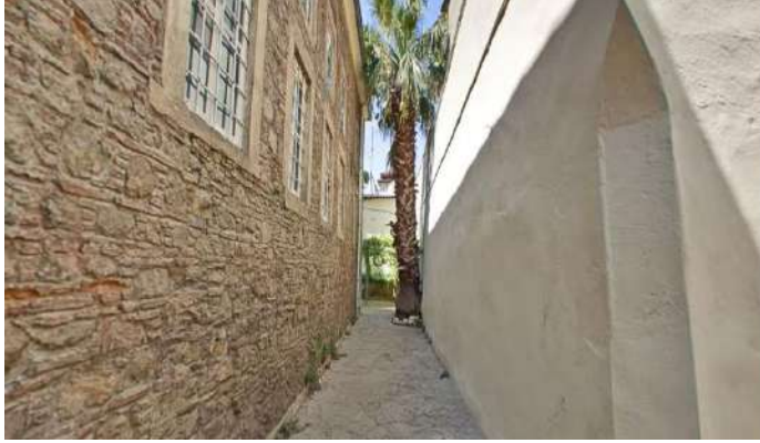
Görsel 12. Yapının Güney Cephesi ( https://tr.pinterest.com/pin/348888302396158547/ ).
